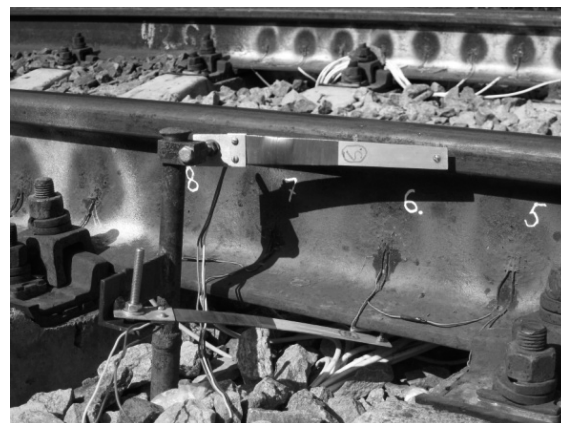
Рис. 3. Общий вид установки датчиков перемещений для регистрации вертикальных и горизонтальных перемещений рельса Fig. 3. General view of the installation of motion sensors for vertical and horizontal displacements of the rail
