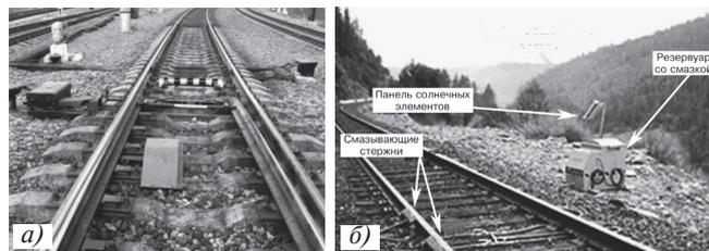
Рис. 3. Стационарные (путевые) рельсосмазыватели:
