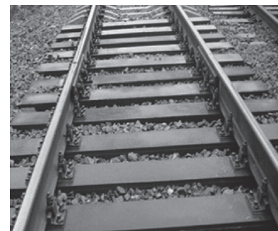
Рис. 2. Шпалы с полимерной оболочкой на Экспериментальном кольце АО «ВНИИЖТ» (ст. Шербинка)
