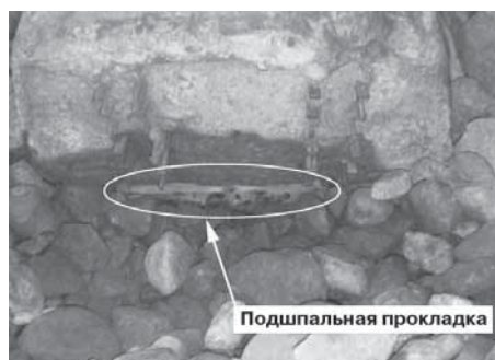
Рис. 5. Расположение подшпальной прокладки под стыковой шпалой
