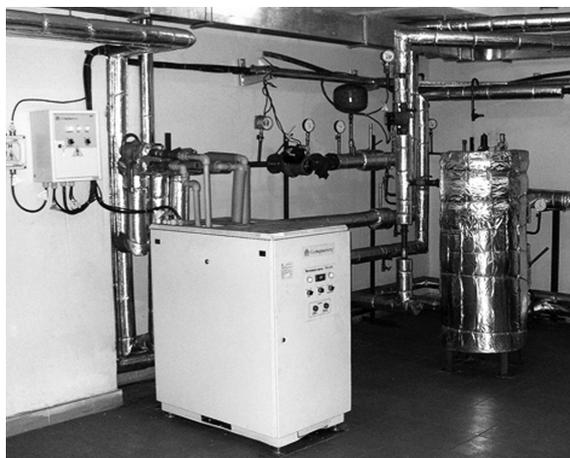
Рис. 2. Теплонасосная установка типа «воздух — вода» на ст. «Михалово», Минский метрополитен
