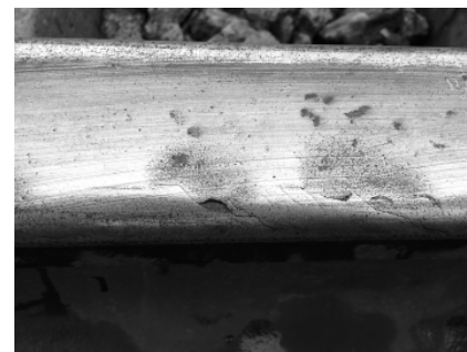
Рис. 4. Параллельные трещины контактной усталости на рабочей выкружке головки рельса и мелкие выкрашивания металла по ним
