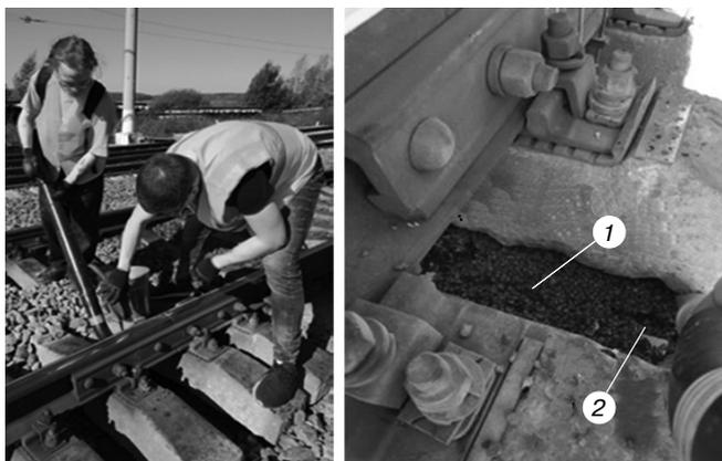
Рис. 5. Выправка пневматическим суфляжем с использованием специально окрашенного гранитного щебня фракции 5–10 мм (1) и разделительной сетки (2)
