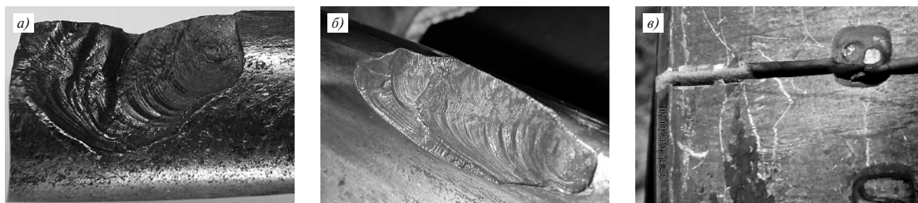
Рис. 2. Дефекты на гребне бандажей марки «2» в виде усталостных трещин и отколов (а, б) и излом бандажа по знаку маркировки (в)
