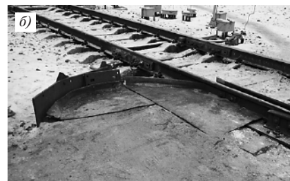
Рис. 7. Конструкция фартуков башмакосбрасывателей: а — на станции Лихая; б — на станции Сольвычегодск
