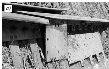
Рис. 7. Конструкция фартуков башмакосбрасывателей: а — на станции Лихая; б — на станции Сольвычегодск
