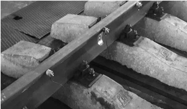
Рис. 5. Установка пьезоэлектрических вибропреобразователей на головку рельса Fig. 5. Installation of piezoelectric vibration transducers on the rail head
