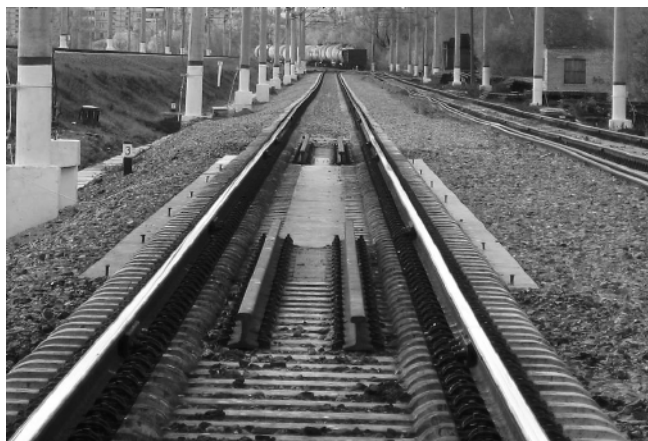
Рис. 1. Опытный участок пути на Экспериментальном кольце ОАО «ВНИИЖТ»
