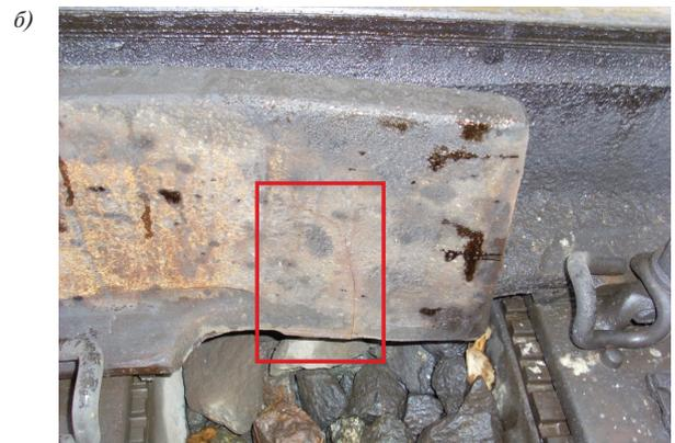
Рис. 12. Трещины литой части цельнолитого блока моноблочной крестовины в районе улавливающего желоба:
