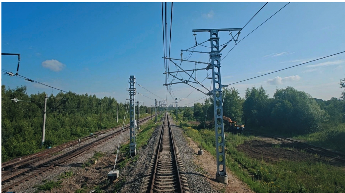
Рис. 5. Контактная сеть КС-400 на Экспериментальном кольце АО «ВНИИЖТ»*
