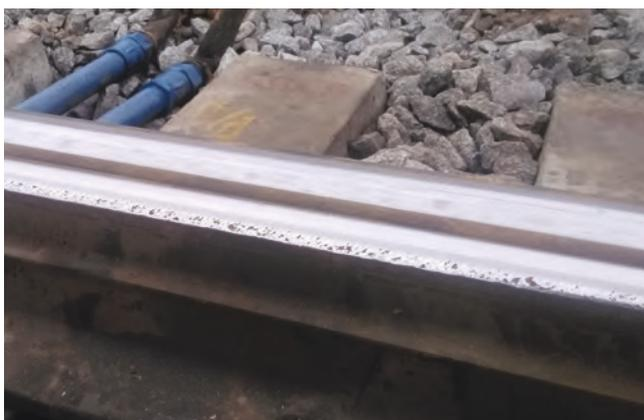
Рис. 3. Выкрашивание металла на рабочей поверхности остряка типа P65 из-за воздействия колес с повышенной нагрузкой
