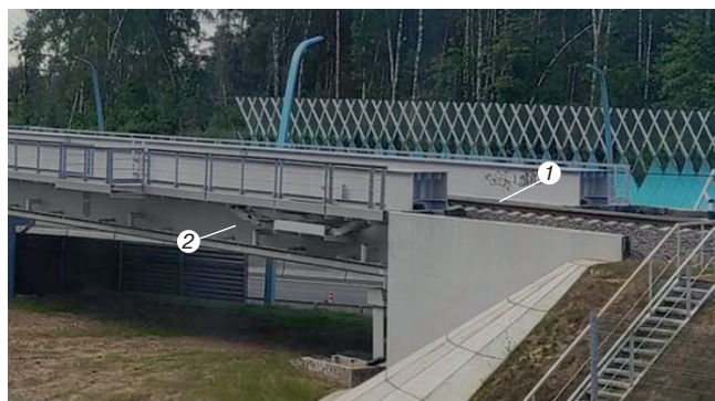
Рис. 1. Железнодорожный путепровод с расположением рельсошпальной решетки (1) в средней зоне балочного пролетного строения (2)
