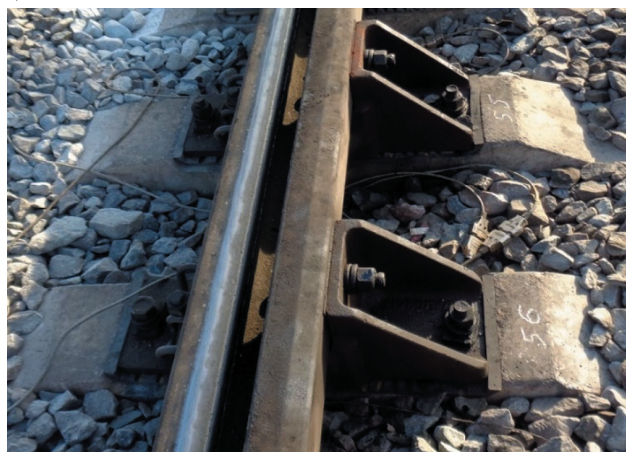
Рис. 4. Опытные контррельсовые подкладки, уложенные в путь для проведения испытаний*: а — вид сбоку; б — вид сверху * Фото автора
